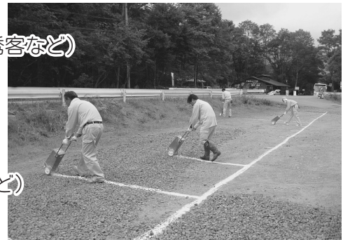
戸隠キャンプ場 駐車場のライン引き作業
