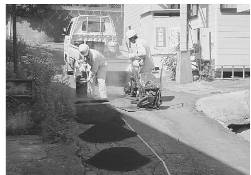
市道の補修作業
