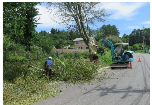
道路沿いの支障木を伐採しました
